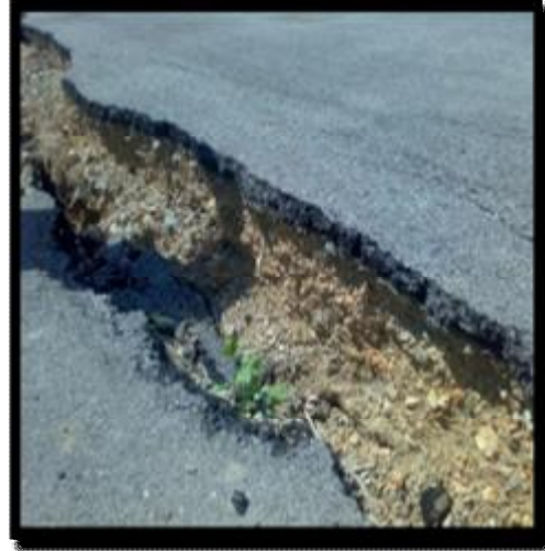
الشكل (1) نموذج التشققات في الطرق التخديمية في منطقة سهل الغاب في سورية
