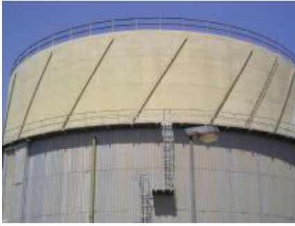
الشكل (3) خزان تجميع الغاز
